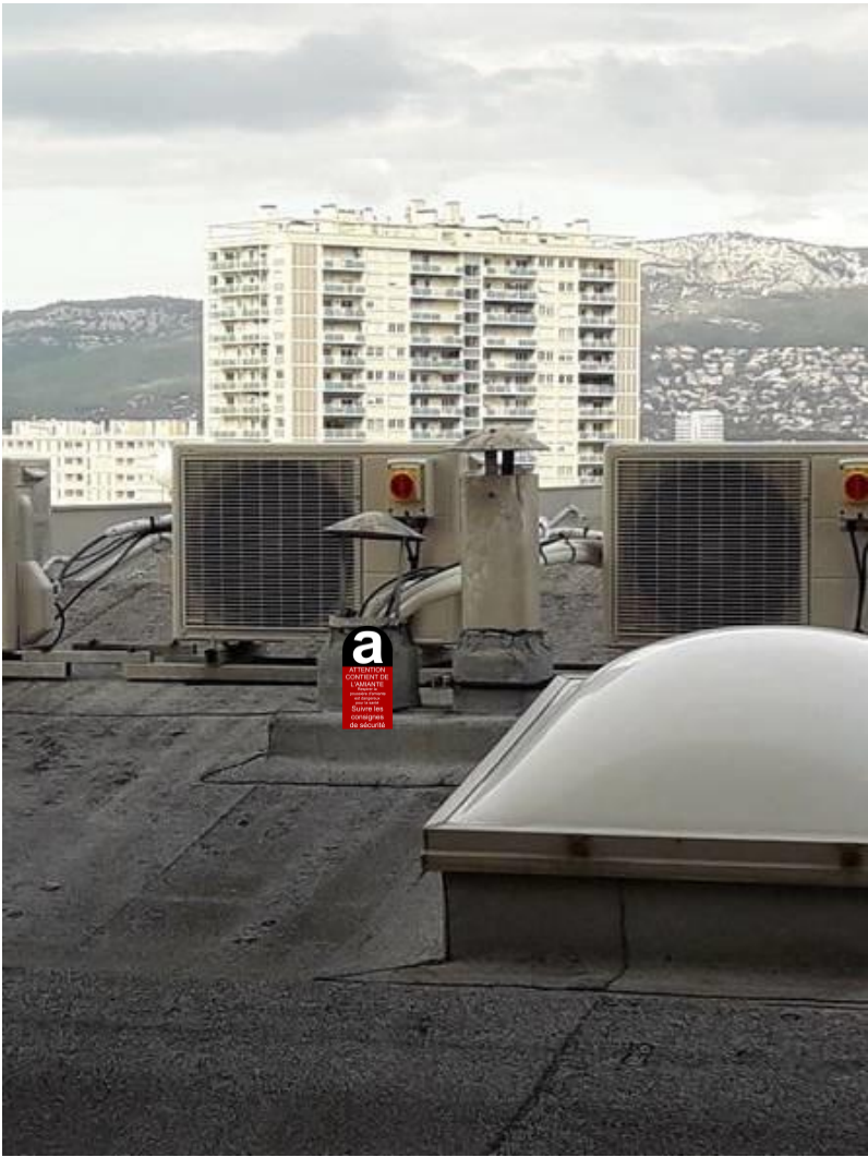
Toiture (5ème étage) - Conduit de fumée - Fibre ciment
