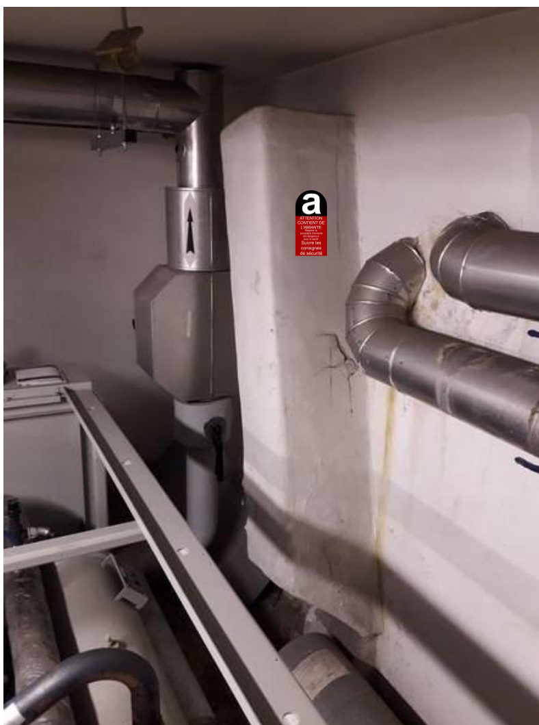
Production eau glacé (Sous-sol 2) - Conduit - Fibre ciment
